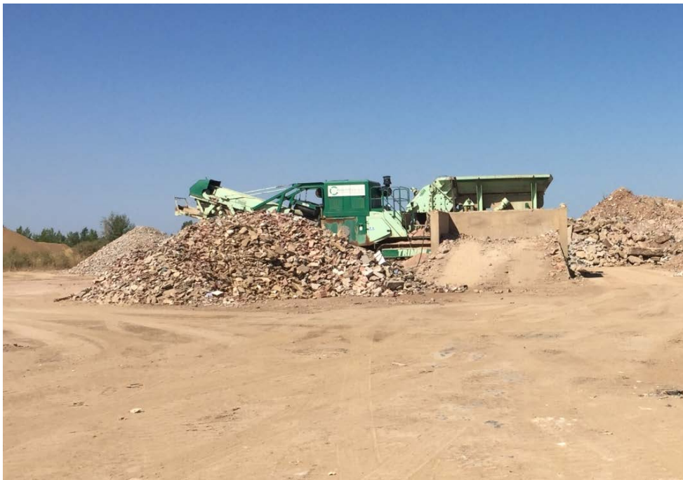
FOTOGRAFÍA 10: EQUIPO MOVIL TRITURACIÓN INSTALADO EN UNA PLANTA DE RCD
