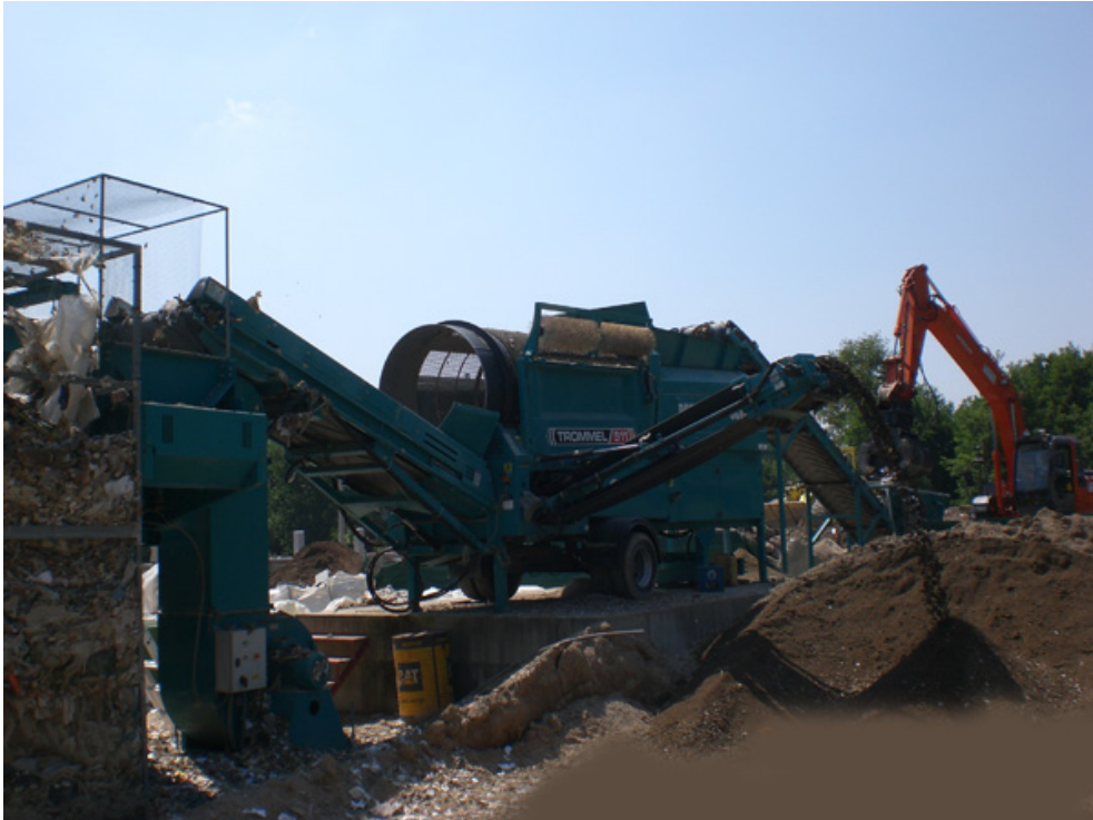
FOTOGRAFÍA 11: PLANTA DE VALORIZACION CRIBADO Y SOPLADO DE VOLATILES
