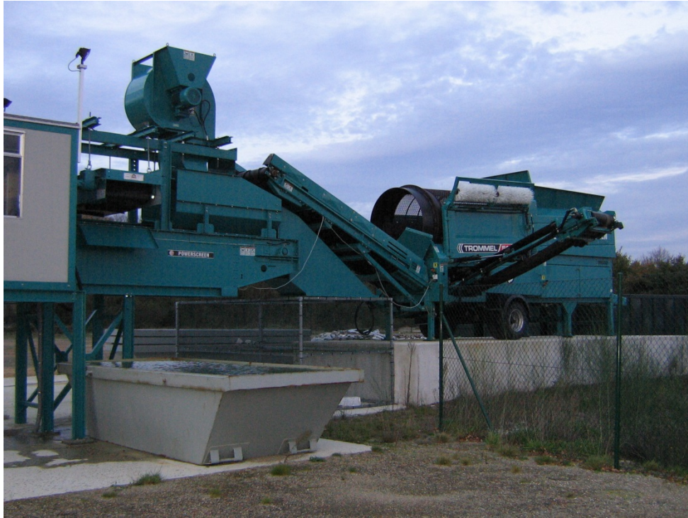
FOTOGRAFÍA 4: VISTA LATERAL DE LA INSTALACIÓN CON TROMMEL, VENTILADOR Y BANDA DE SEPARACION MAGNETICA
