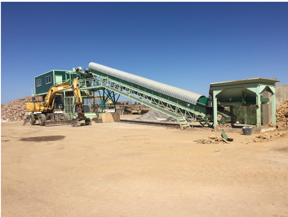
FOTOGRAFÍA 12: PLANTA DE VALORIZACIÓN CON SOPLADO Y CABINA DE TRIAJE
