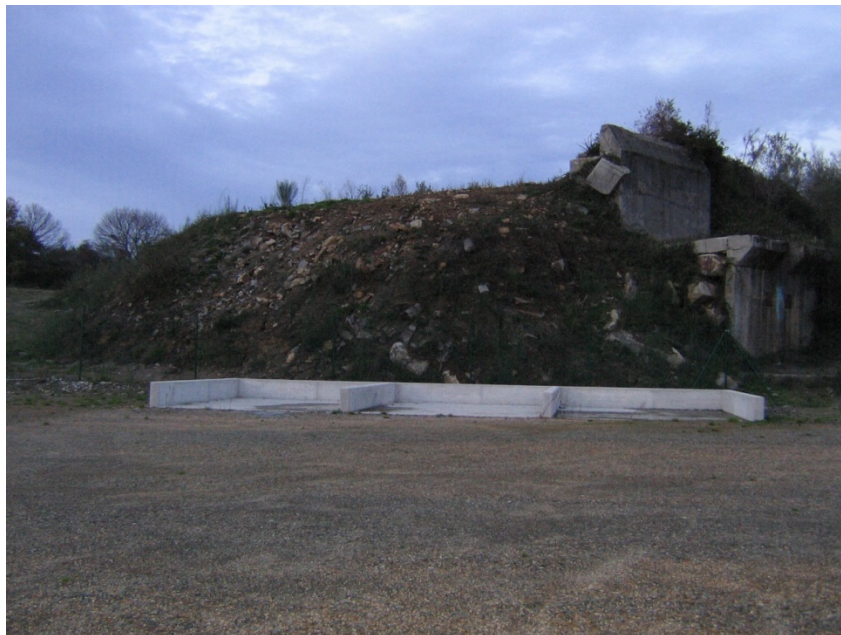
FOTOGRAFÍA 7: ZONA DE ALMACENAMIENTO DE RESIDUOS PELIGROSOS
