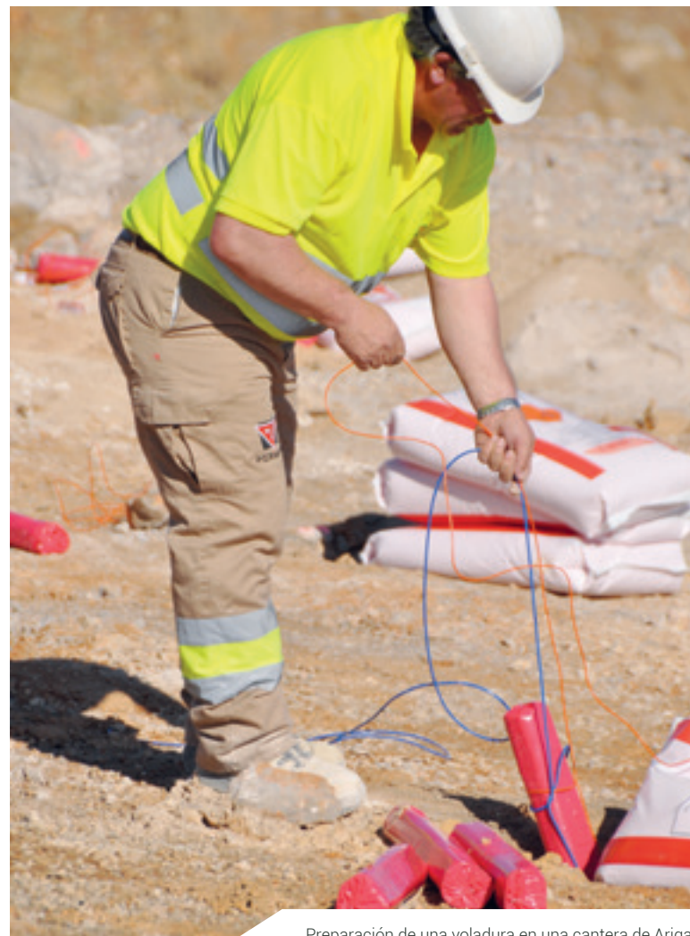
Preparación de una voladura en una cantera de Arigal.
