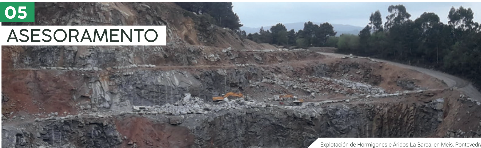
Explotación de Hormigones e Áridos La Barca, en Meis, Pontevedra.
